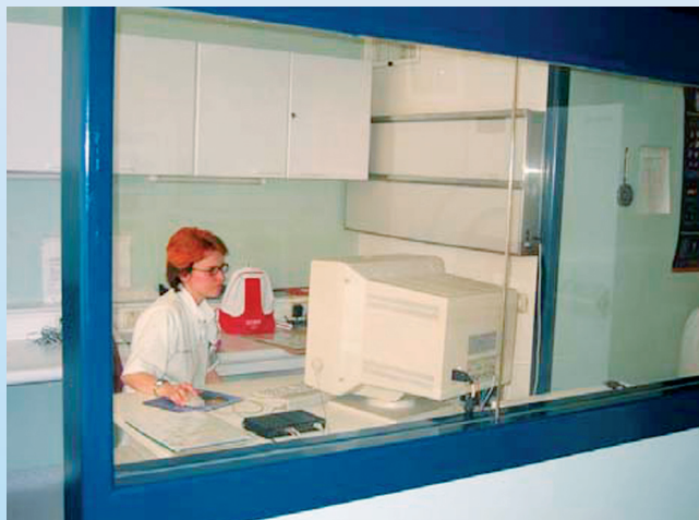
Slika 6: Zaščitno steklo v nadzornem prostoru SPECT-CT (Grmek, 2004)
